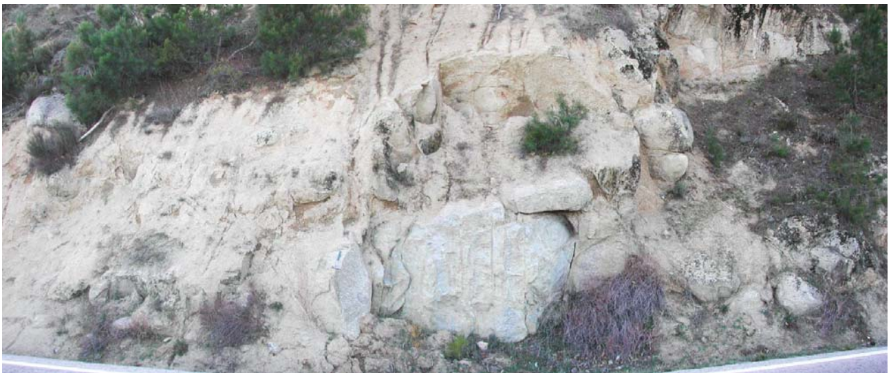
Figura 27: Algunas formas de erosión del granito son heredadas de su alteración previa en el subsuelo. Las zonas de fractura están más alteradas y se erosionan más fácilmente, mientras que los núcleos no están tan alterados y aguantan mejor la erosión.
